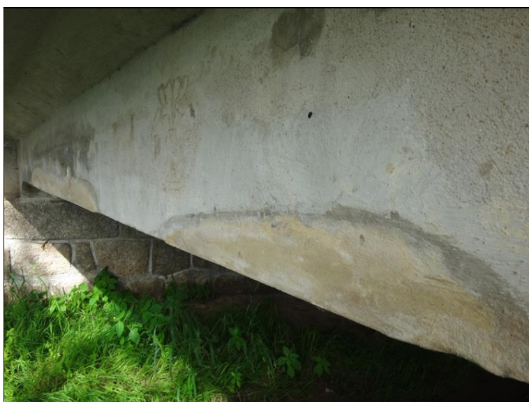
Poruchy a lokální opravy NK
